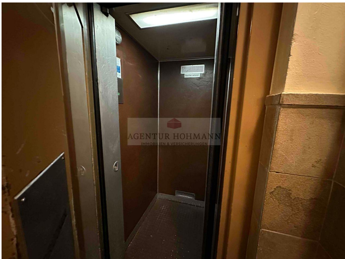
Aufzug im Haus
