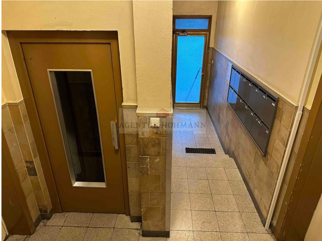
Aufzug im Haus
